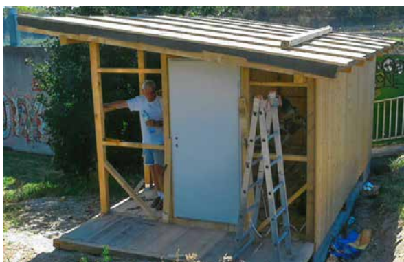
Puis ce fut au tour du revêtement bitumé du toit et du montage de la porte d'entrée, ...
