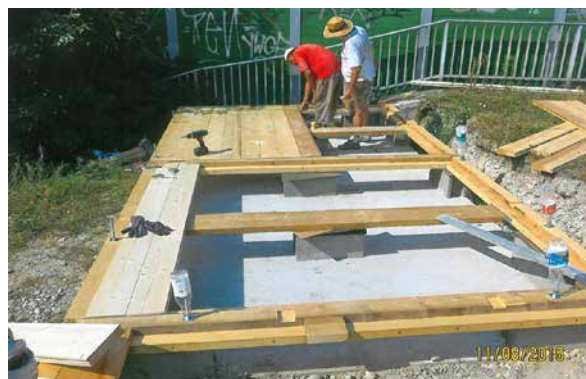
Après la pose du sol ...
