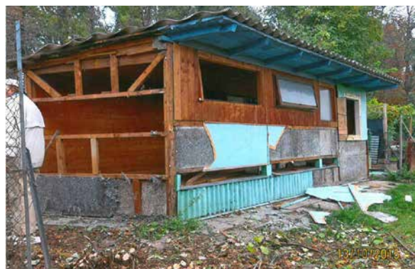
... car maintenant la destruction de l'ancien abri peut commencer.
