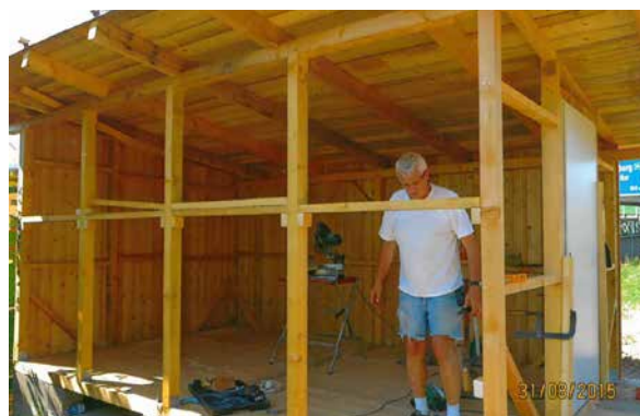
... et enfin l'habillage des murs.
