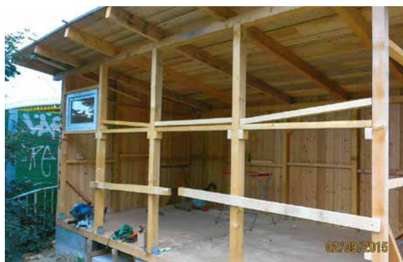
La première fenêtre est posée et s'imbrique parfaitement ...
