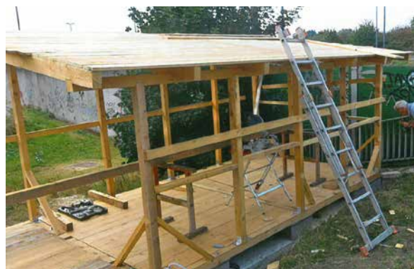
... et poser les planches du toit.
