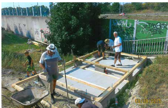
Ensemble, nous avons posé les fondations et la dalle.
